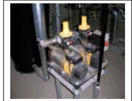
Die DPA ASPRI 20-5 ist komplett auf einer aus PE bestehenden Bodenplatte montiert. Das Sammelrohr hat ein 6/4“ Innengewinde und ist aus Edelstahl gefertigt. Der Pumpenmantel, die Welle und die Laufräder sind ebenfalls aus Edelstahl. Für die Saug- und Druckgehäuse wurde Alpha- Messing verwendet. Die Gleitringdichtungen bestehen aus Kohle / Keramik, das Leitrad ist aus Noryl. Für das Motorgehäuse wurde das Leichtmetall L-2521 verwendet.
