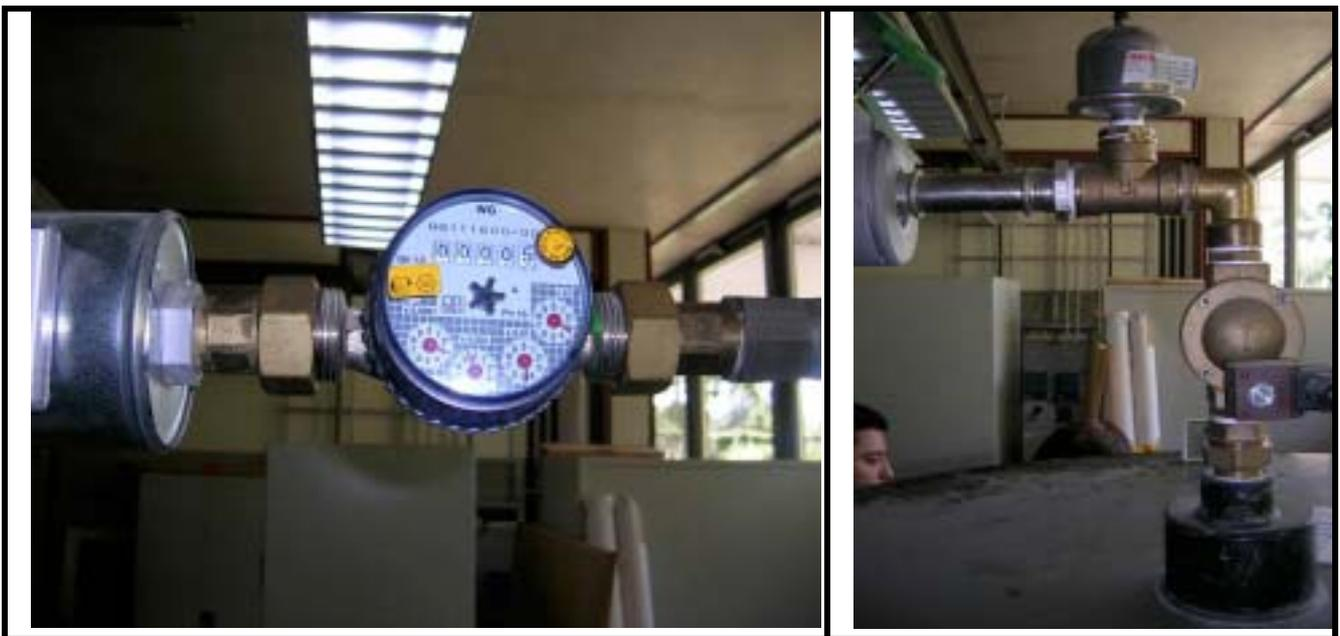
Zur Abrechnung bei den Berliner Wasserbetrieben sitzt vor dem Magnetventil ein Wasserzähler. Vor und hinter ihm sind Schrägsitzventile installiert, die seinen Austausch zu Reparaturzwecken ermöglichen. Ein Entlüfter sorgt dafür, dass die eingeschlossene Luft aus der Leitung entfernt wird, da sie das Strömungsverhalten des Wassers beeinflusst und zu Mikro-Druckschäden bei den Armaturen und Einbauteilen führen kann.
