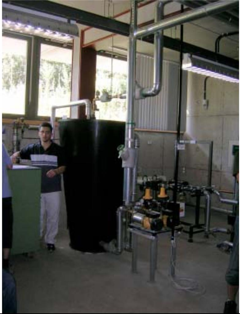
Am oberen Ende des Innentanks sind 2 Eingänge und 1 Ausgang angebracht. Rein kommen der Regenwasserzulauf und die Trinkwassernachspeisung, raus der Überlauf.
